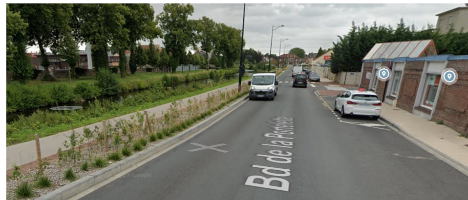
Traversée d'Abbeville dans le cadre de l'aménagement de la véloroute callée de Somme
